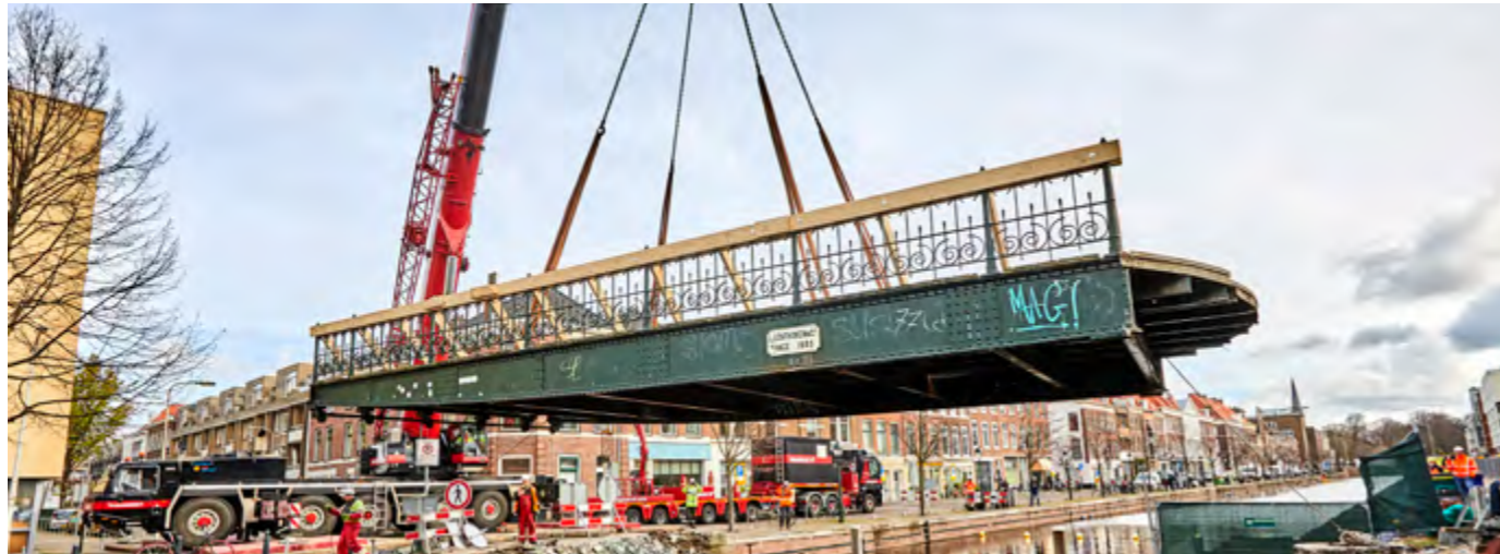
Restauratie Hemsterhuisbrug, Den Haag
