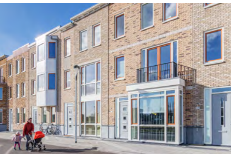
Nieuwbouw woningen RijswijkBuiten
