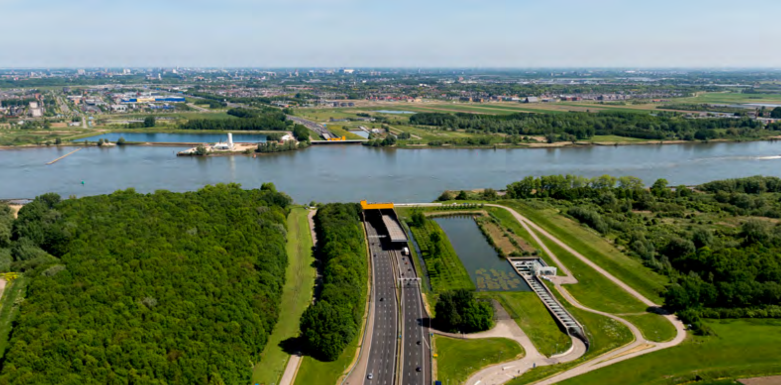
Renovatie Heineoordtunnel, A29 Barendrecht
