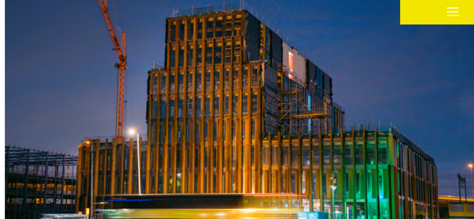
Het van een houten constructie voorziene nieuwe regiokantoor van Alliander, Amsterdam-Westpoort
