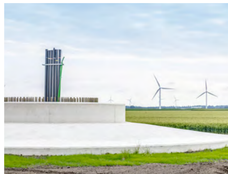
Bouw fundering windpark Zeewolde
