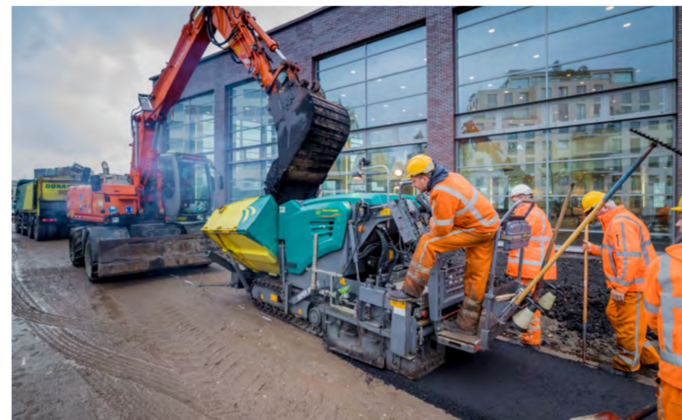
Asfalteringswerkzaamheden Overhoeks, Amsterdam
